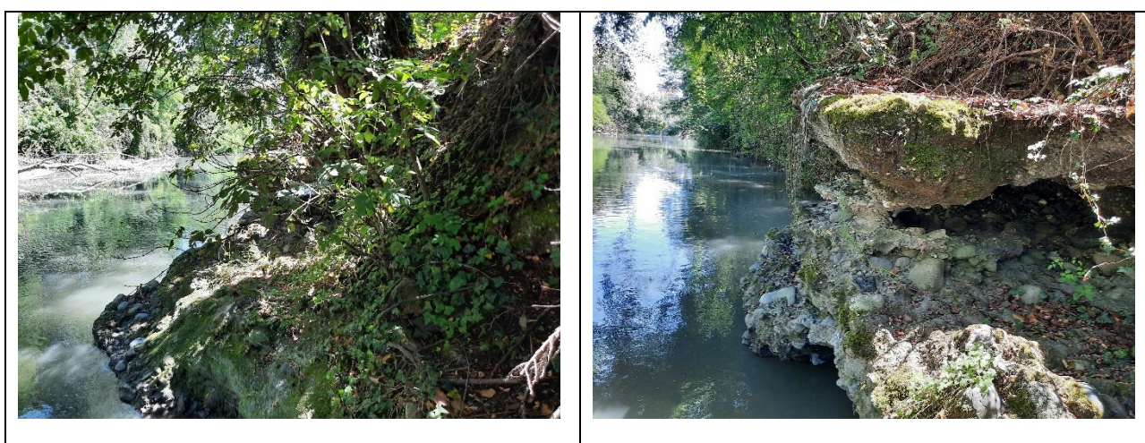
Figura 3 – Difesa spondale ammalorata nei pressi delle sezioni 3 (SX) e 4 (DX).
